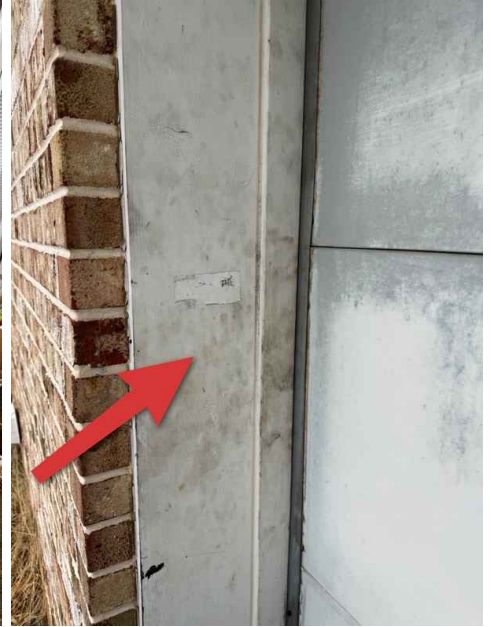
Garage Door Jamb
